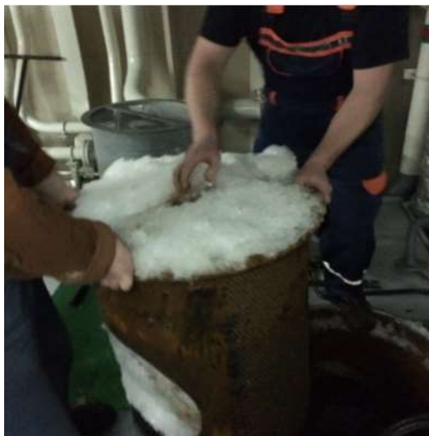
Рисунок 7 – Колотый лед в заборном контуре системы охлаждения
