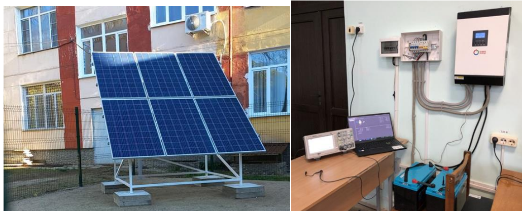
а) б) Рисунок 1 – а) солнечные панели, б) инвертор
